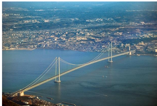
Figura 82: Ponte Akashi-Kaikyo - Japão
